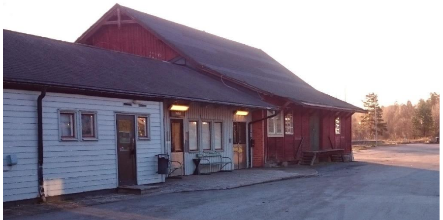
Godsmagasinet och det år 1968 byggda stationshuset, från "gatusidan", den 27 november 2016.
