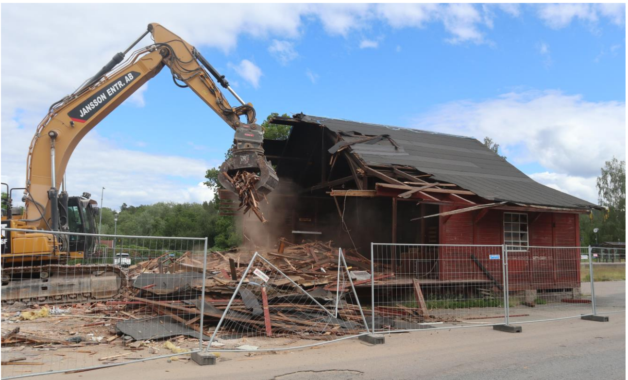
Rivningen den 17 juni 2020.
