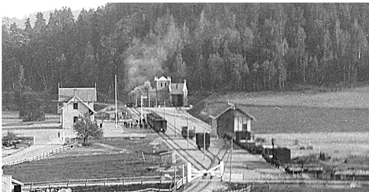
Kisa station 1902 eller 1903 med stationshuset till vänster på banans östra sida, lokstallet i fonden med det vidbyggda vattentornet, vid vilket tågloket till tåget på spår I hämtar vatten, samt godsmagasinet vid och över spår IV, här i ursprungligt skick. Spår III byggdes först 1905. Träkolsbrygga på bangårdens västra sida tillkom senare. Bilden från Kinda lokalthistoriska arkivs samling.
