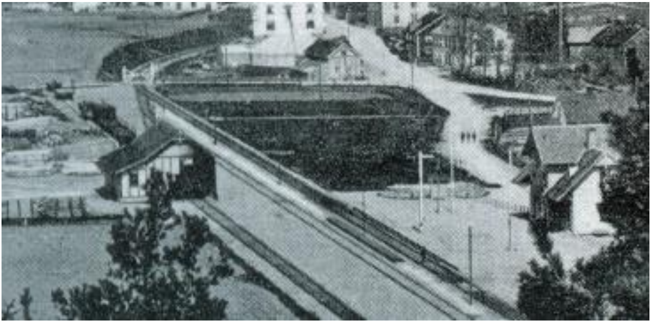
Godsmagasinet med den tillbyggnad åt "gatusidan" som gjordes 1903, del av bild, Per-Olov Brännlunds samling.
