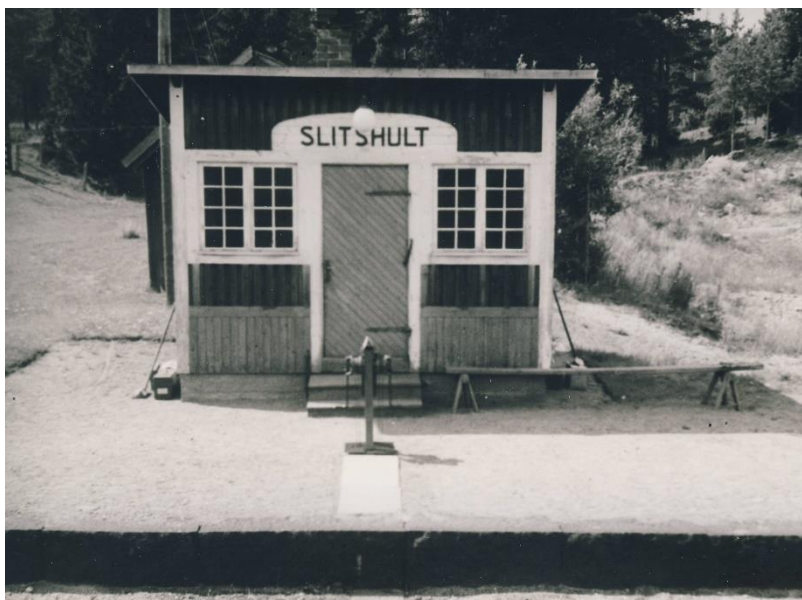
Hållplatskuren på 1940-talet med ställverk för semaforerna och en bänk att invänta tåget på
