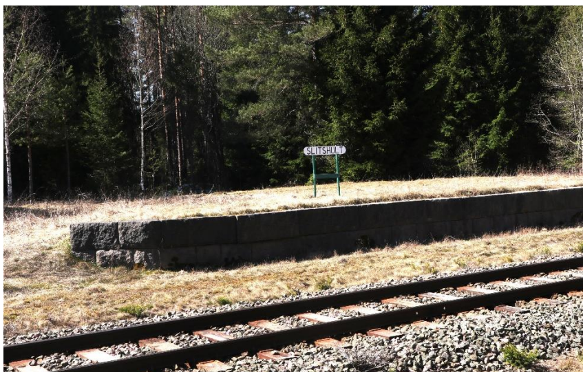
Lastkajen i gott skick och försedd med stationsskylt. Foto 2023.
