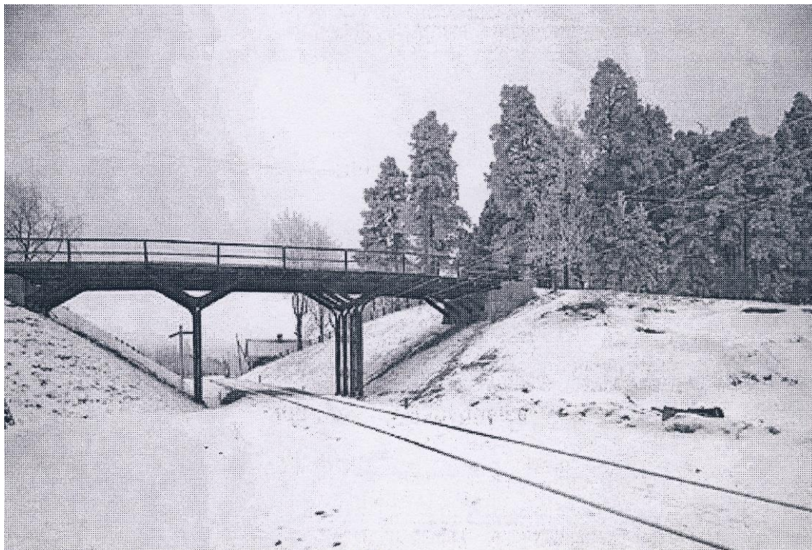
I södra delen av bangården i Södra Vi byggde ÖCJ en av sina fem vackra vägbroar av räler. I bakgrunden skymtar Vistad banvaksstuga.
