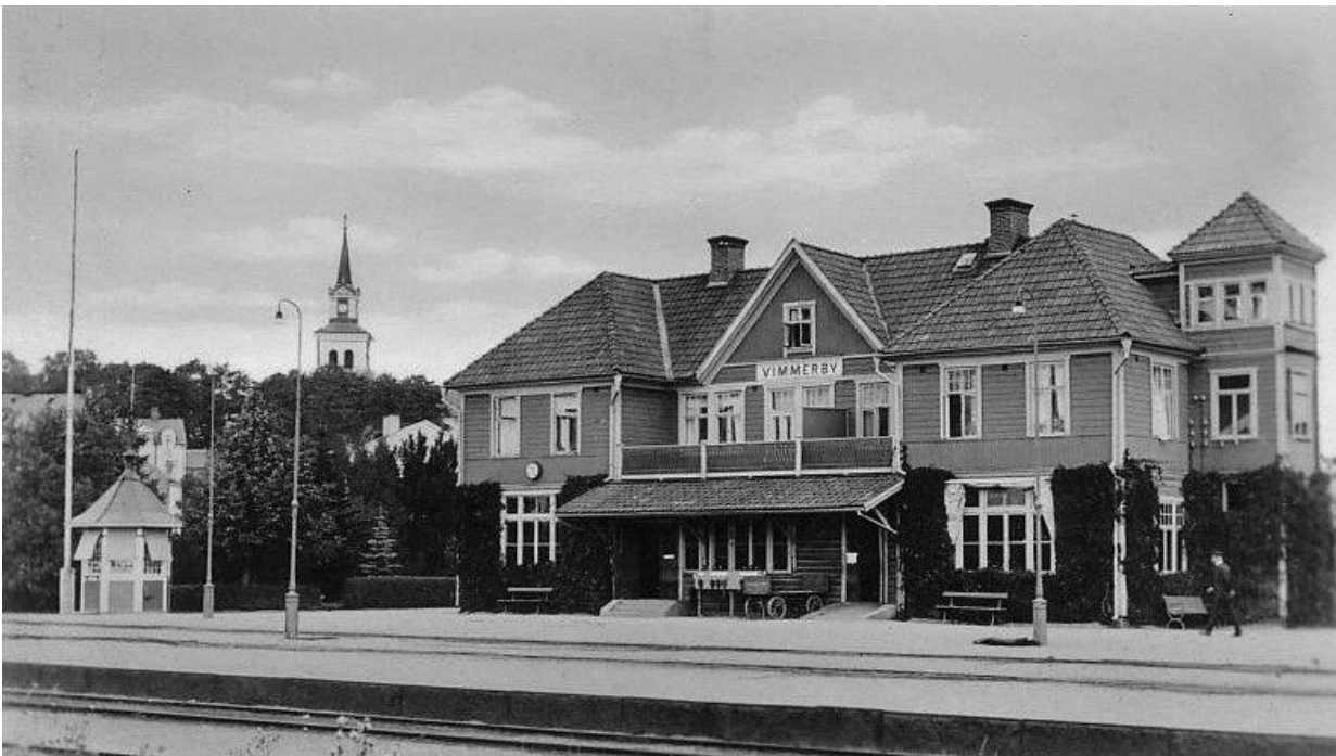
Vimmerby stationshus 1934 med ÖCJ:s spår närmast.
