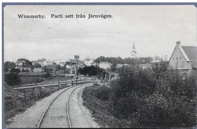
VSJ:s infart till Vimmerby med en skivsignal. Lokstallet med murkrön i högra bildkanten.
