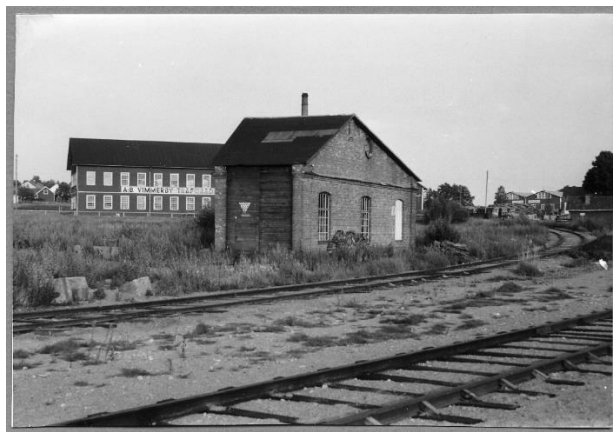
VSJ:s lokstall har ombyggts till ovanstående utförande vid okänd tidpunkt. Bild från 1963.
