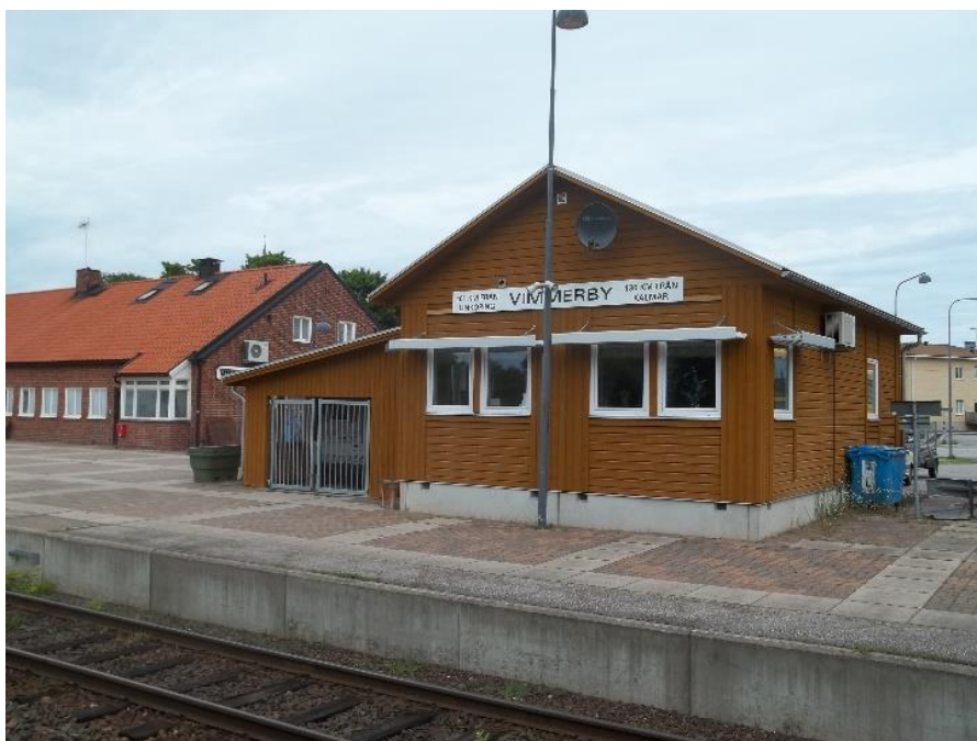
Detta så kallade "teknikhus" togs i bruk den 9 juni 2011. Det inrymmer den nuvarande tågklarareexpeditionen. Ställverket, av typen vev- apparat, uppsattes 1930. Det finns ännu 2024 kvar innanför de på bilden låsta grindarna. Vevarna togs bort den 30 sep- tember 2010, varefter manövreringen av ytter- växlarna sker elektriskt. Namnskylden med avstånden till Linköping och Kalmar upp- sattes av Stångådalensbanans Vänner den 19 juni 2013.
