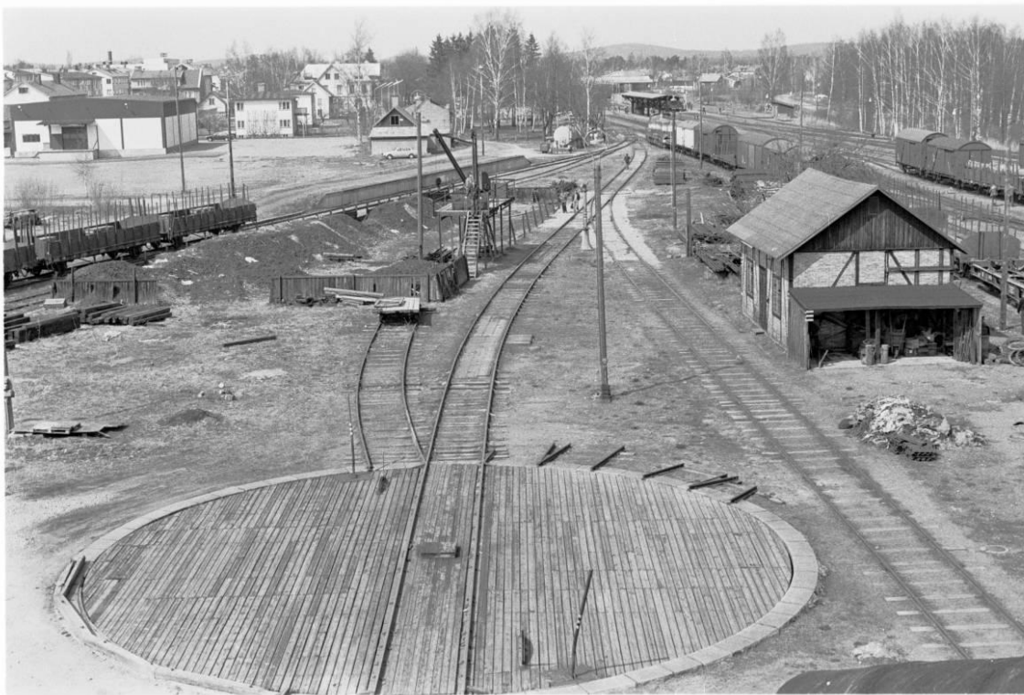
Vy över lokstallsområdet sett från vattentornet.
